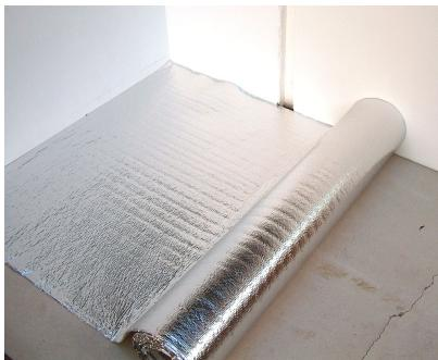
MAGNUM Isorol je reflektujuća folija, na jednoj strani prekrivena metaliziranim PET filmom 12μ. Koristi se kao podloga za MAGNUM Cable (uz pretpostavku da postoji dovoljno strukturalne snage). Podna površina treba biti očišćena, te glatka i suva. Ako su neravne površine veće od 2 mm/m, moraju se izravnati. Folija se polaže s PET slojem na vrhu. Spoj se mora povezati s posebnom aluminijskom/poliesterskom trakom, koja se naručuje posebno.
